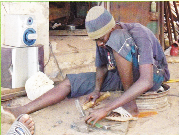
Een leerling-lasser aan het werk in het Skillcentre.
